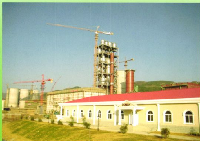
贵定海螺盘江水泥有限责任公司，项目建设规模为年产水泥440万吨，第一期年产220万吨水泥生产线已于2009年底初步建成。图为项目建设场景。
