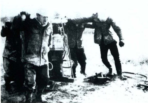
人拉肩扛转运钻井设备（1976年）
