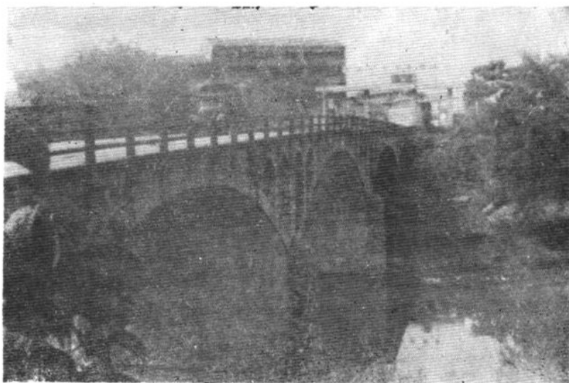
◁县道公路桥—红都糖厂大桥
