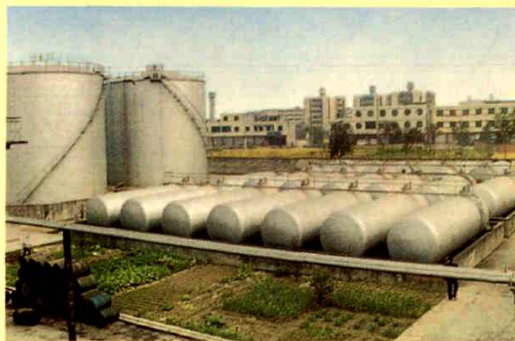
德阳石油公司油库一角
