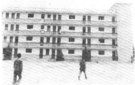
集资兴建的县二中教学楼
