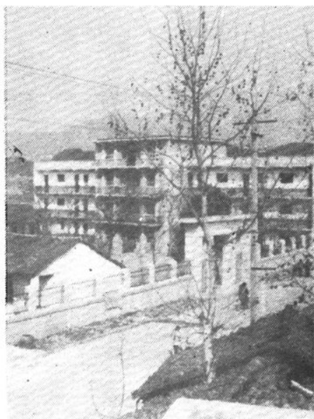
省重点小学七里坪列宁小学教学楼
