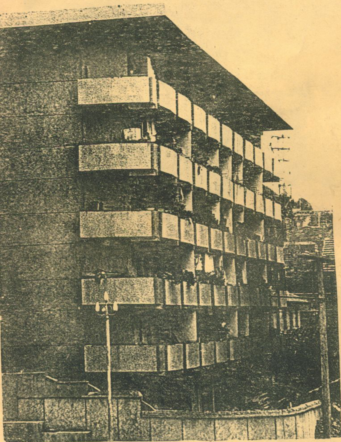
▲ 阿坝藏族羌族自治州 群众艺术馆办公宿舍大楼
