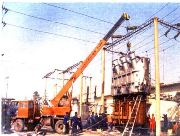
110千伏樊口变电站1#变压器大修现场（1991年11月21日）
