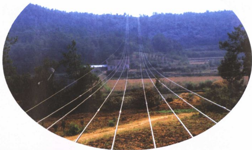
左 (三峡左岸) 荆 州换流站)500 千伏输 电线路山区架线情景 (2003)
