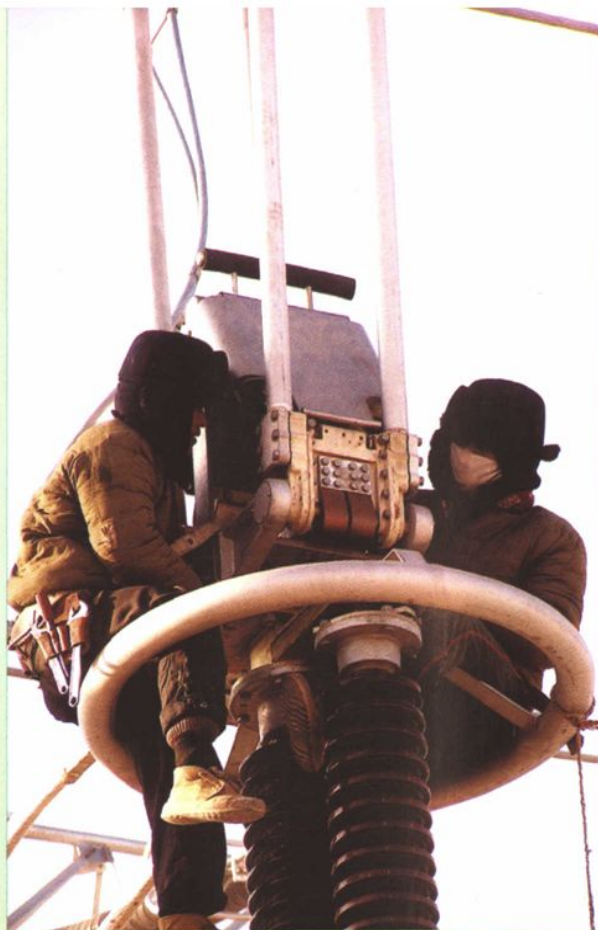
乌海 500 千伏变电站安装设备之情景 (2003)
