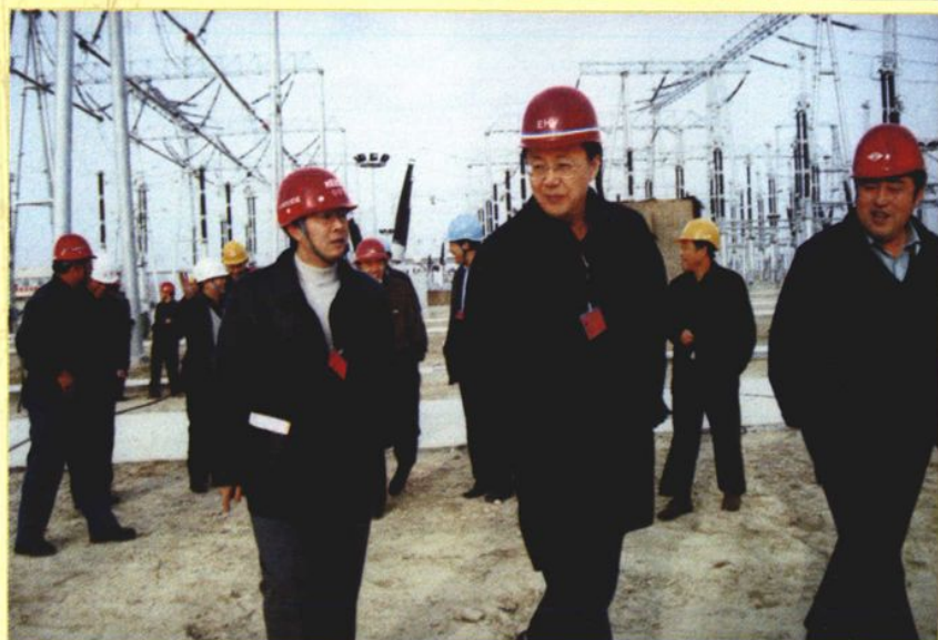
内蒙古电力 (集团)公司董事长 乌若思(前中) 在送变电公司经 理吴景龙(前左)陪 同下视察500千 伏永圣域变电站 工程(2001)
