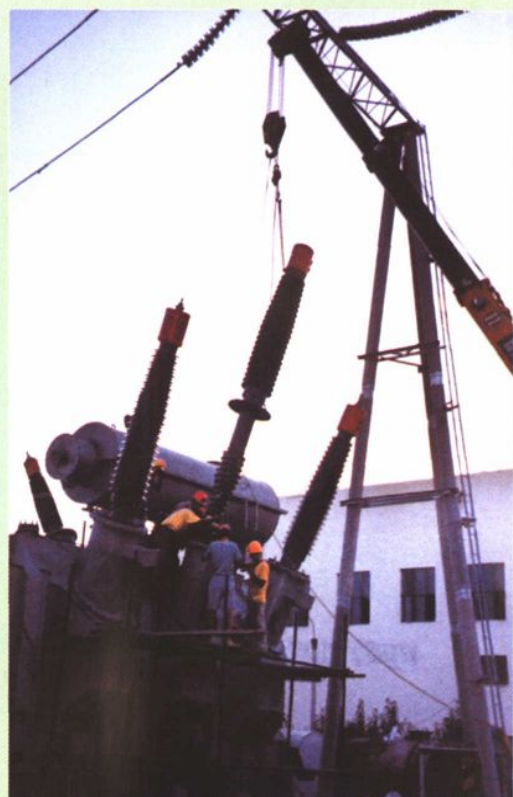
临河 220 千伏变电站扩建工程在 安装主变套管(1999)
