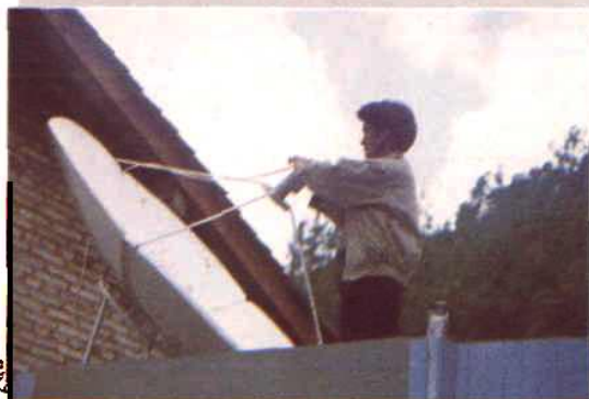
安装卫星接收天线
