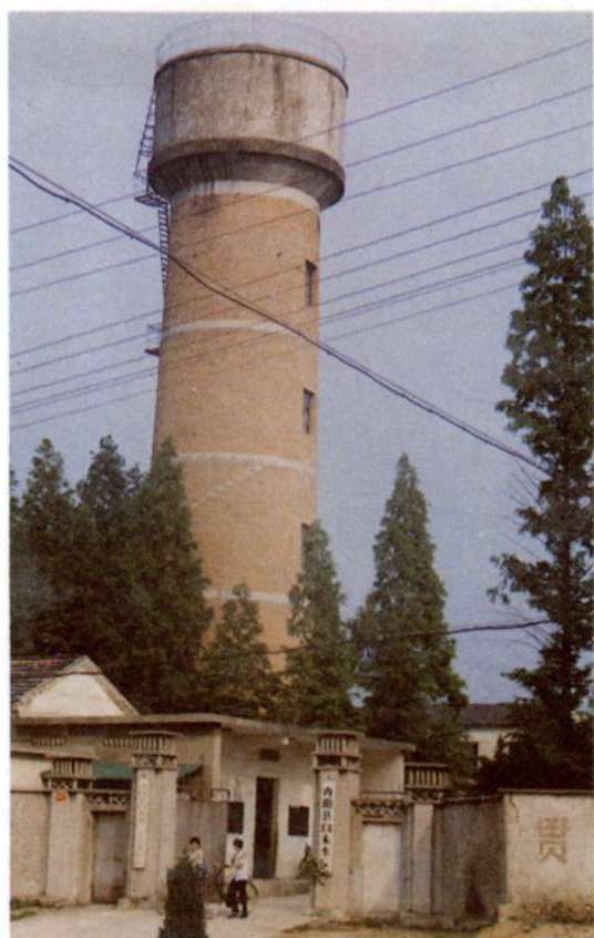
▲县自来水厂水塔
