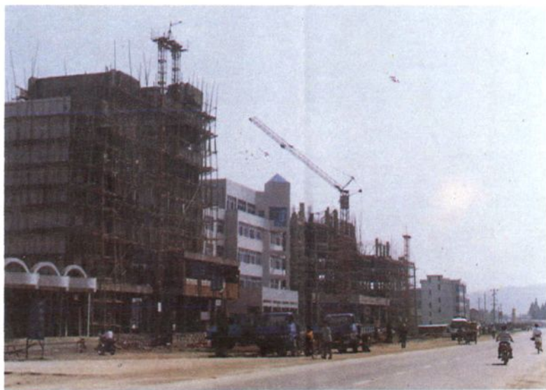
西峰路东段在建工程
