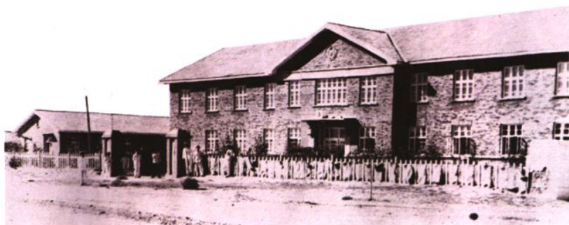
1956年二连卫生检疫所办公楼
