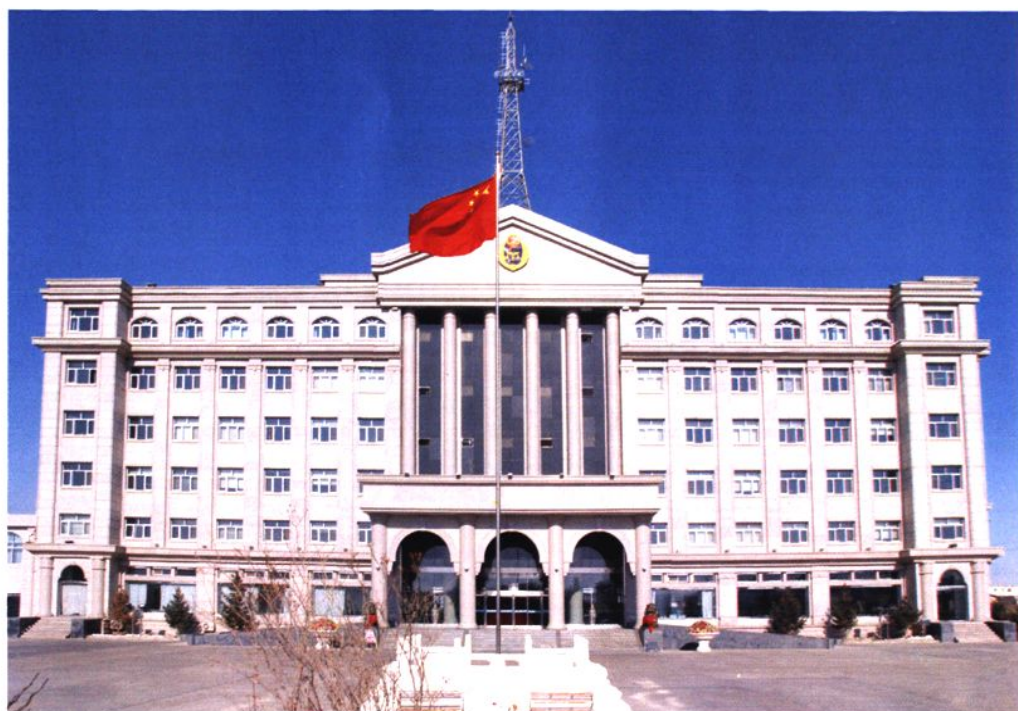
二连浩特检验检疫局综合实验楼
