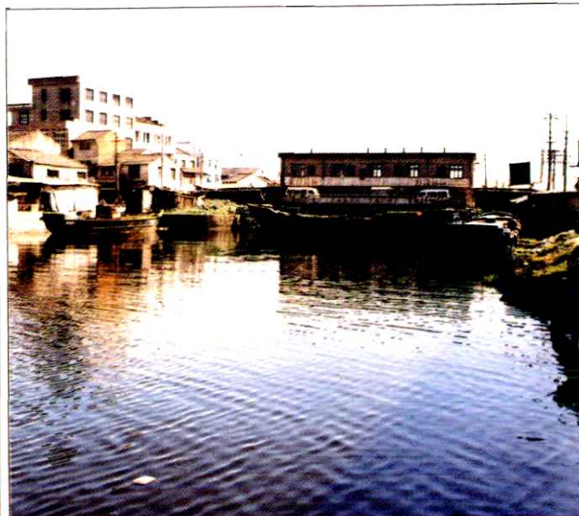
东山下埠水闸
