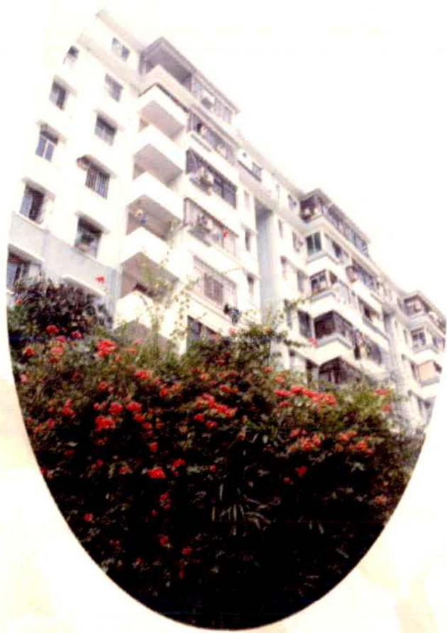
整治后的共和小区 楼房换上了新装
