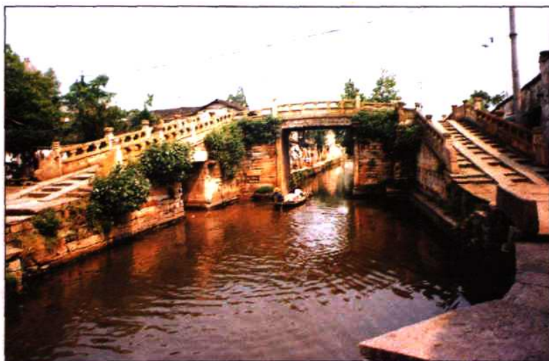
绍兴城区八字桥
