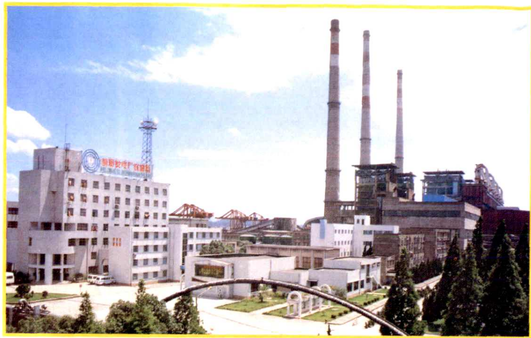
由浙江省电力工业局中心调度所调度的镇海发电厂
