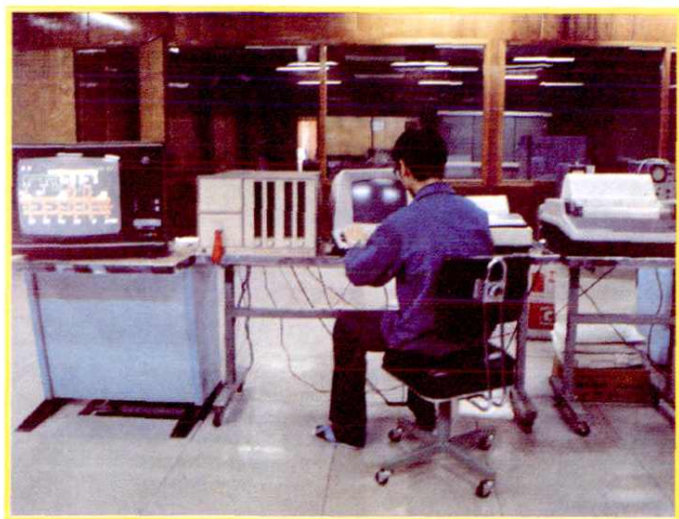
1982 年浙江省电力工业局中心调度所开发的电网微机安全监视系统
