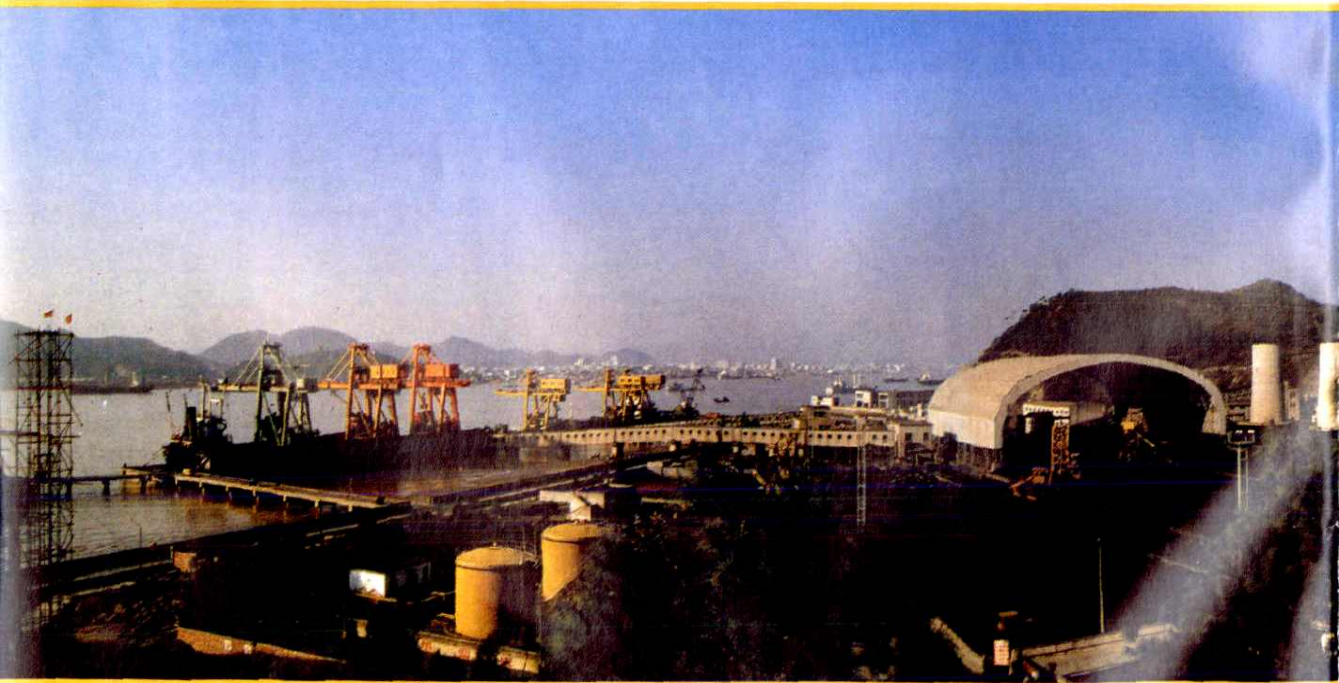
由浙江省电力工业局中心调度所调度的台州发电厂
