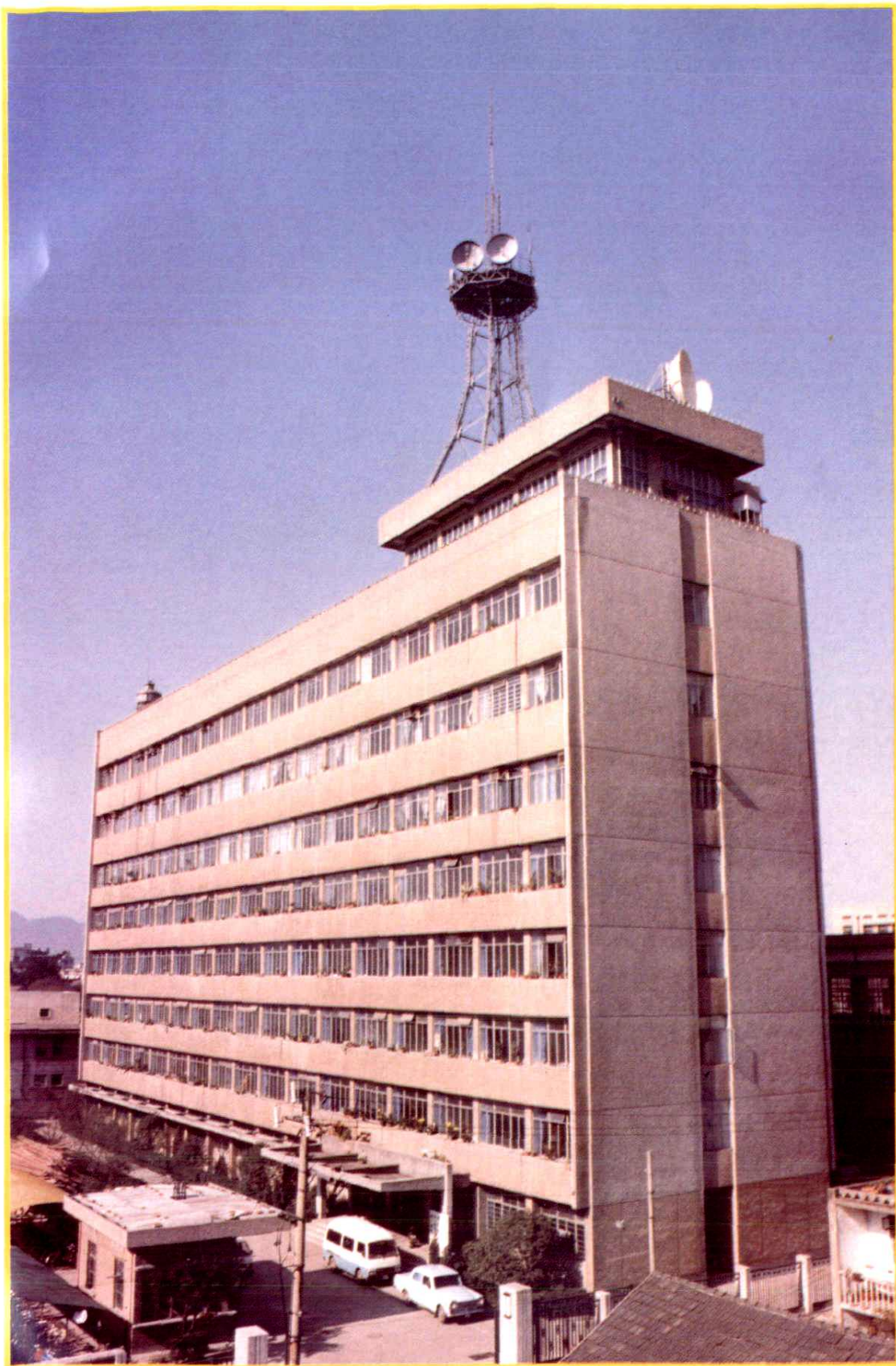
浙江省电力调度大楼
