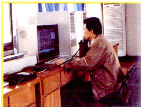
1987 年 4 月电网微机安全实时监视系统在衢州电力局投入运行
