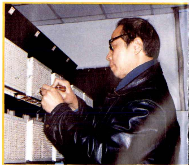
绍兴电力局调度所通信技术人员维修通信设备
