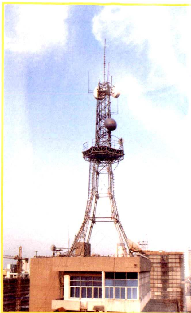
浙江省电力系统微波通信中心
