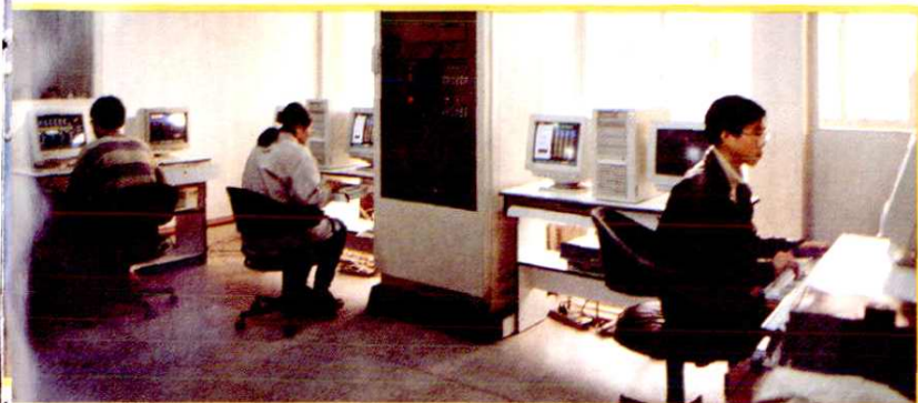
安装在舟山电力公司调度所的电网微机安全实时监视系统
