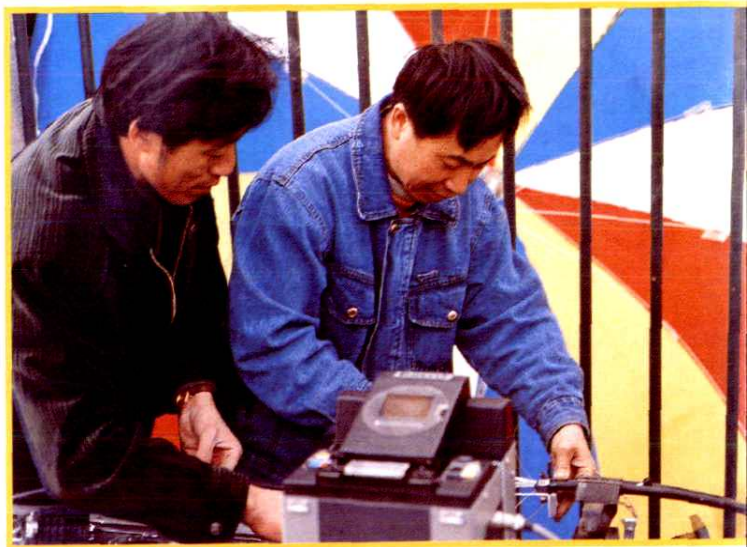
浙江省电力工业局中心调度所通信人员抢修光缆
