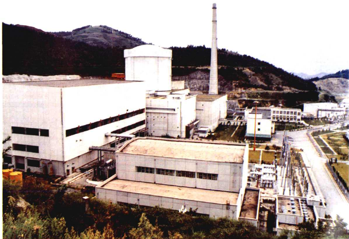
1988 年开工承建秦山核电厂常规岛工程(机组容量 30 万千瓦)。图为秦山核电厂
