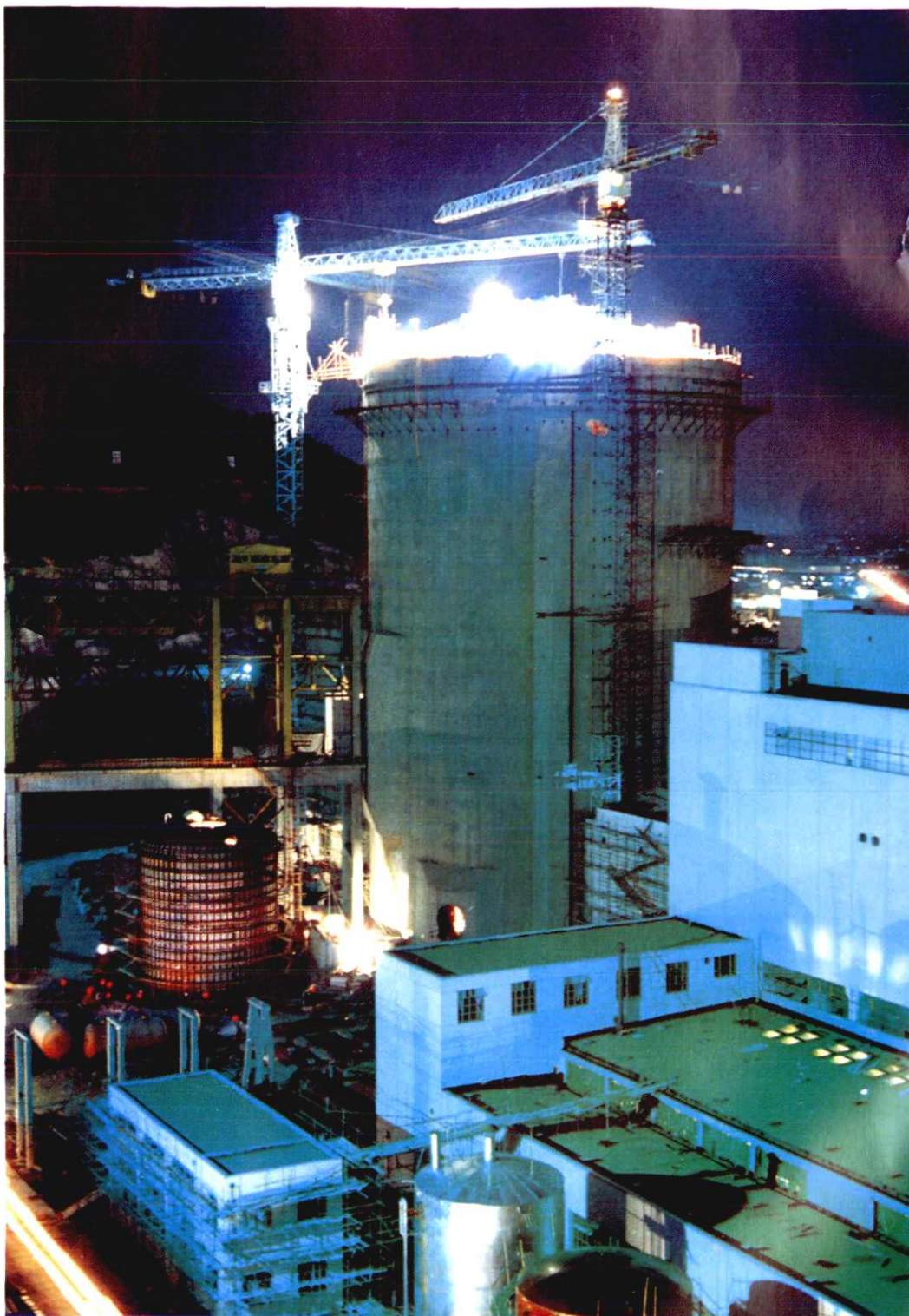
秦山核电厂施工夜景
