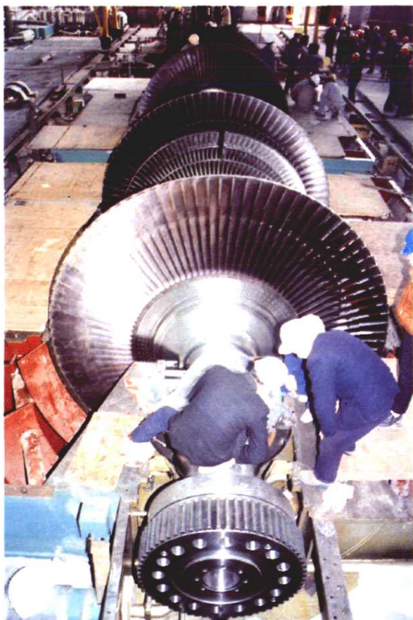
秦山核电厂 30 万千瓦汽轮机安装
