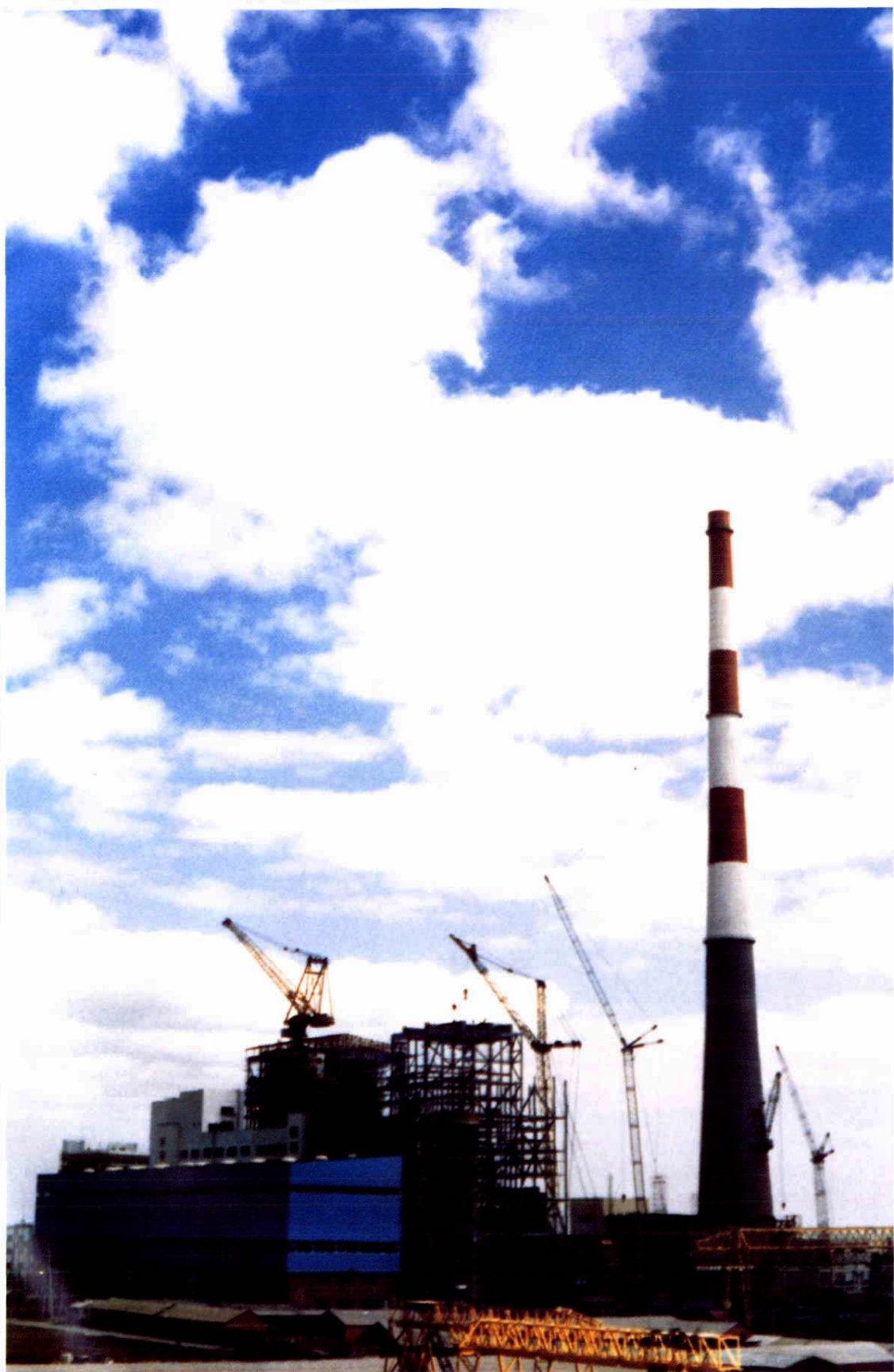
1988 年开工承建的北仑电厂 1 号机组(60 万千瓦)工程在施工中
