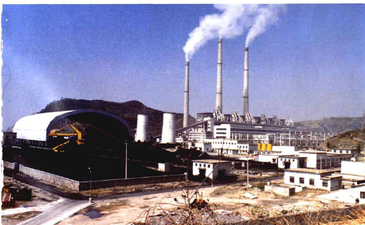
1980~1988年承建的台州电厂工程(装机容量75万千瓦)
