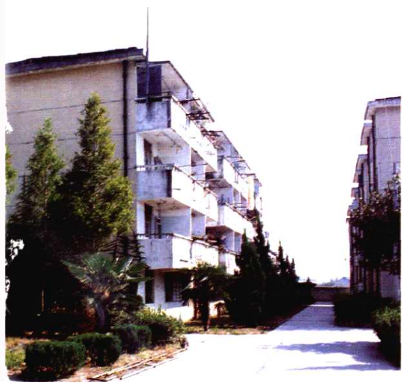
北仑电厂工地职工宿舍
