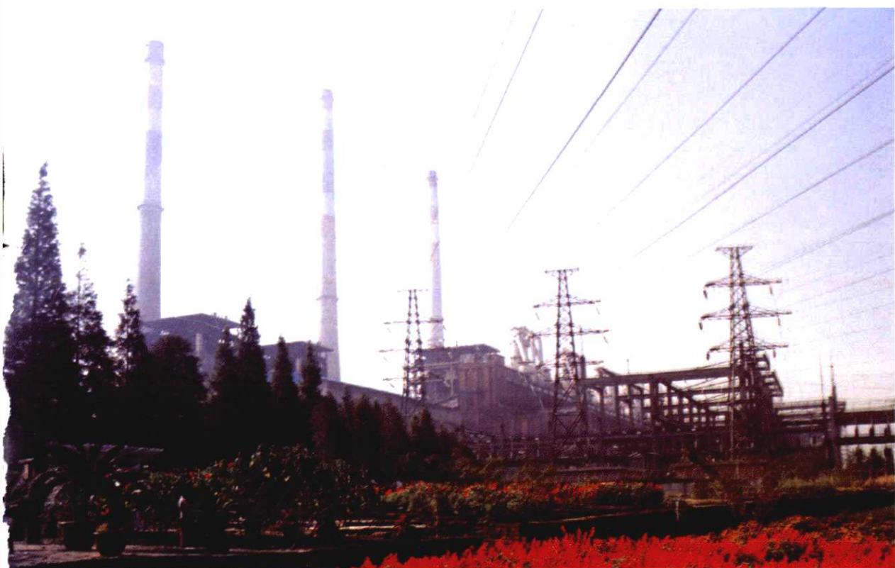
1978~1990年承建的镇海电厂工程(装机容量105万千瓦)
