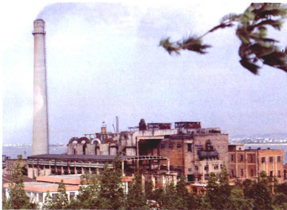
1957 ~ 1959 年扩建的 杭州闸口电厂工程（装机 容量4.7 万千瓦）
