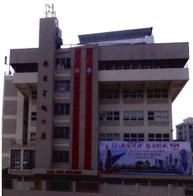
新加坡南安会馆大厦
