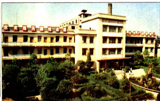
◀ 炼制研究所大楼
