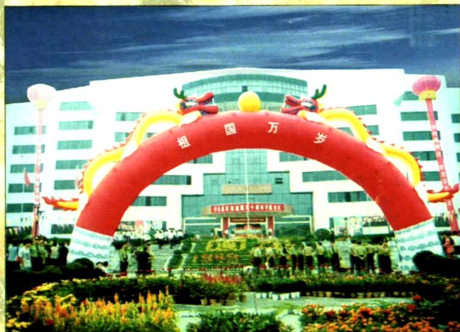
安化县委、县政府办公楼
