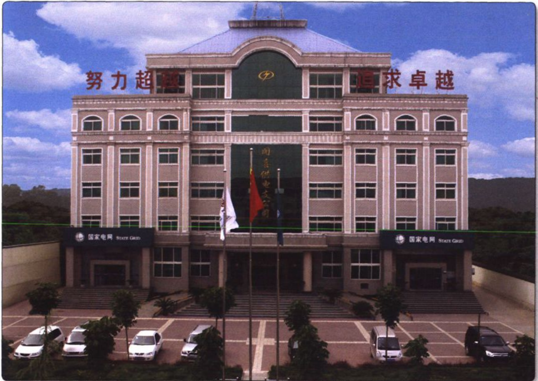
闻喜县电业局办公大楼
