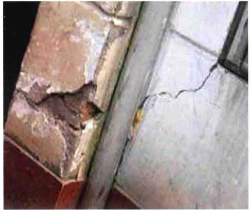
关帝中学教学楼西侧承重墙随地基下陷而开裂
