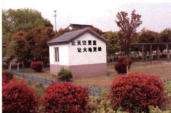
污水处理设施
