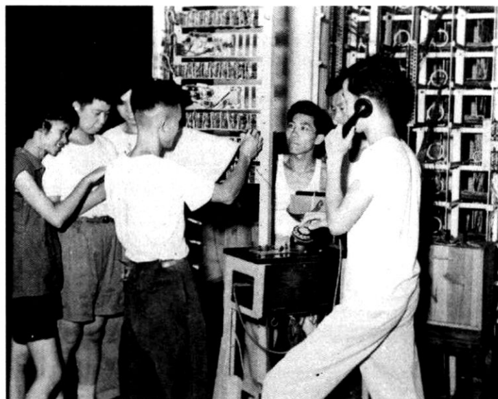
▼1959年长沙电信工人自行研制的长途半自动接续设备,实现长话立接制通话。
