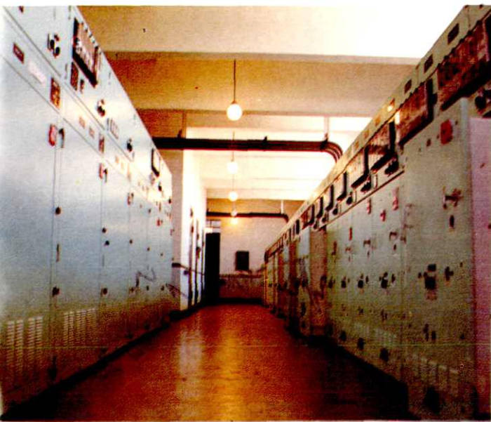
35 千伏陆家嘴变电站（建于 1985 年 12 月）
