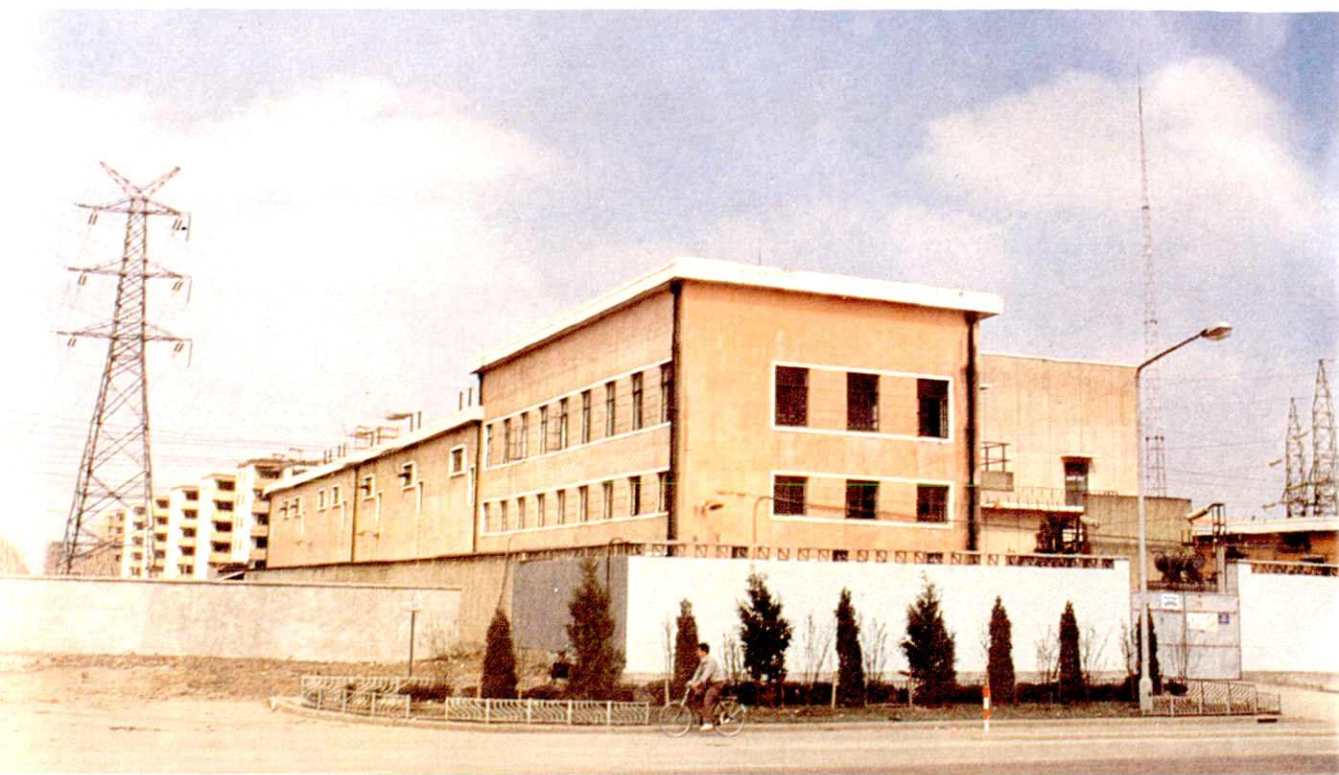
110 千伏金桥变电站（建于 1986 年 9 月）
