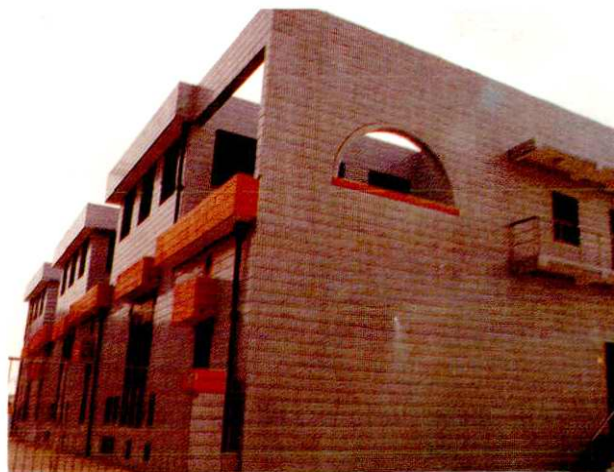
金桥出口加工区第一座全户内布置采用电力电缆进出线的 35 千伏金仙变电站（建于 1993 年 9 月）
