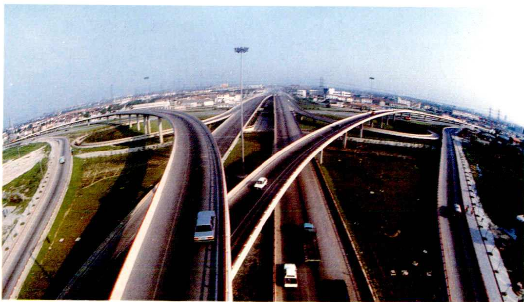
罗山立交桥照明设施
