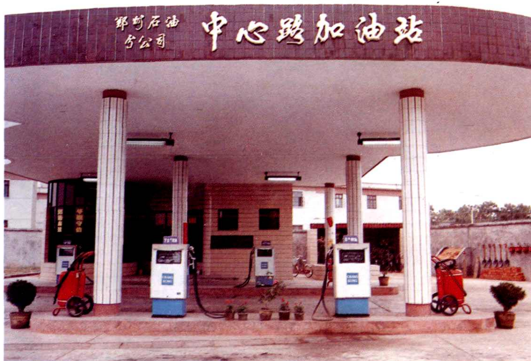
河南省石油总公司郑州分公司郑州市上街区中心路加油站
