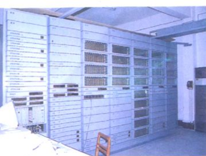
新桥邮电所程控电话电脑控制台
