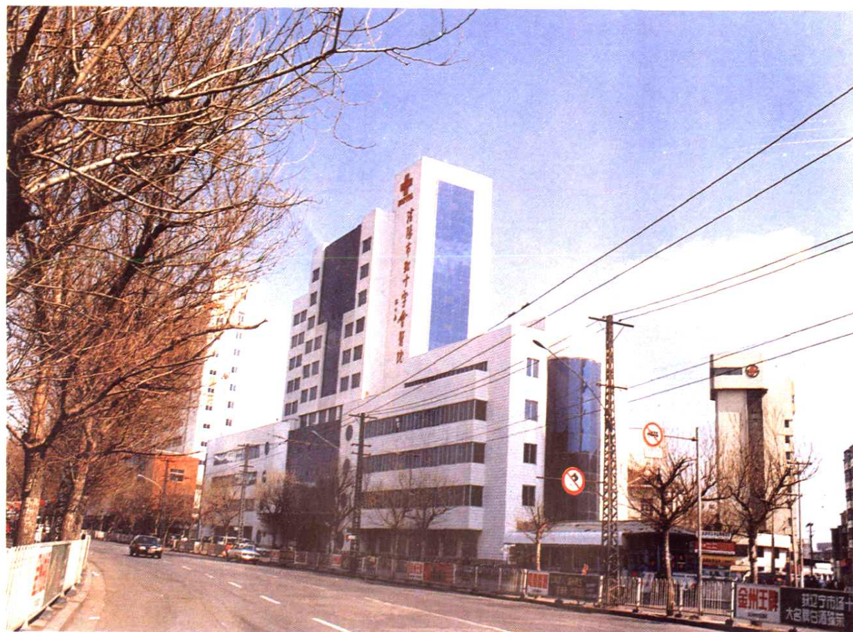
1993 年新建门诊楼
