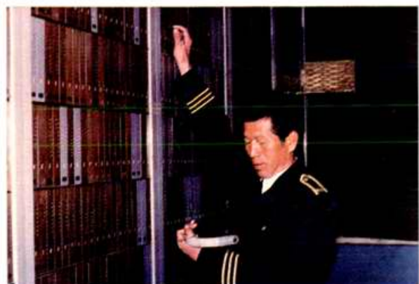
检测 2000 门准电子交换机(1980 年 摄)
