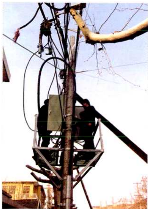
线务员在交接箱站台作业
