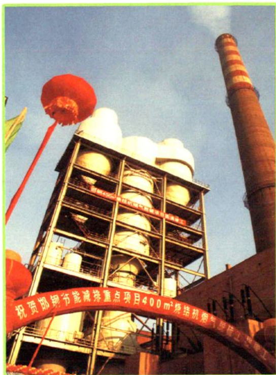
邯钢烧结机脱硫设施
