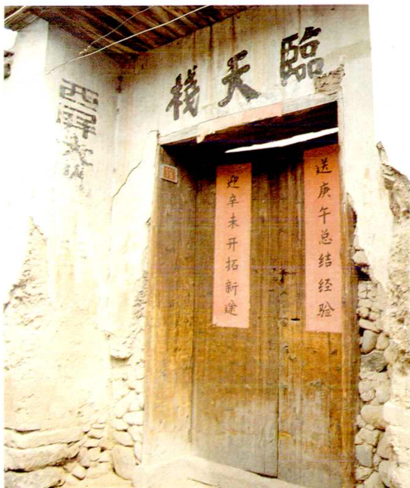
临(海)天(台) 棧烟行旧址
