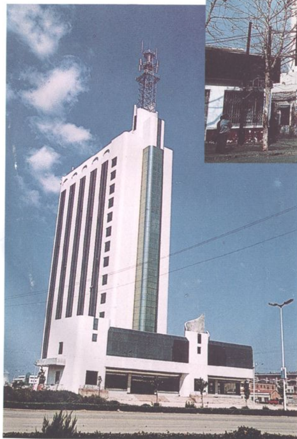
东昌西路 42 分局电信大楼
