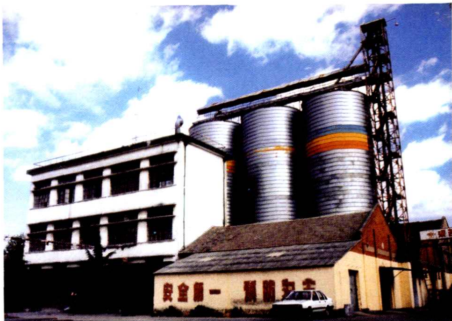
东海县饲料厂饲料车间大楼及钢板仓
