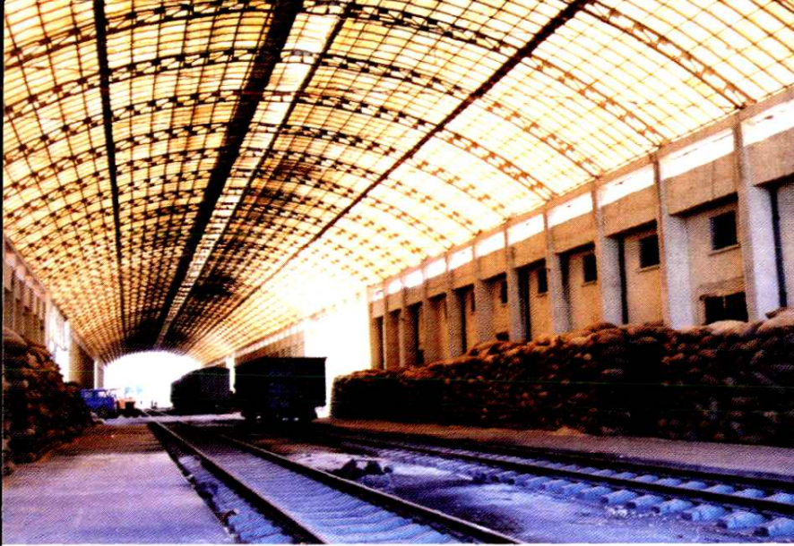
江苏省东海国家粮食储备库 铁路专用线
