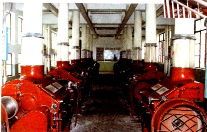
白塔面粉厂制粉车间
