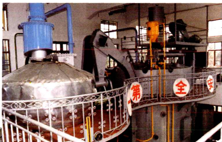
东海县植物油厂浸出车间
