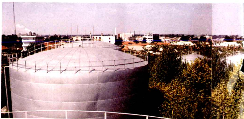
江苏省东海食用油库油罐区
