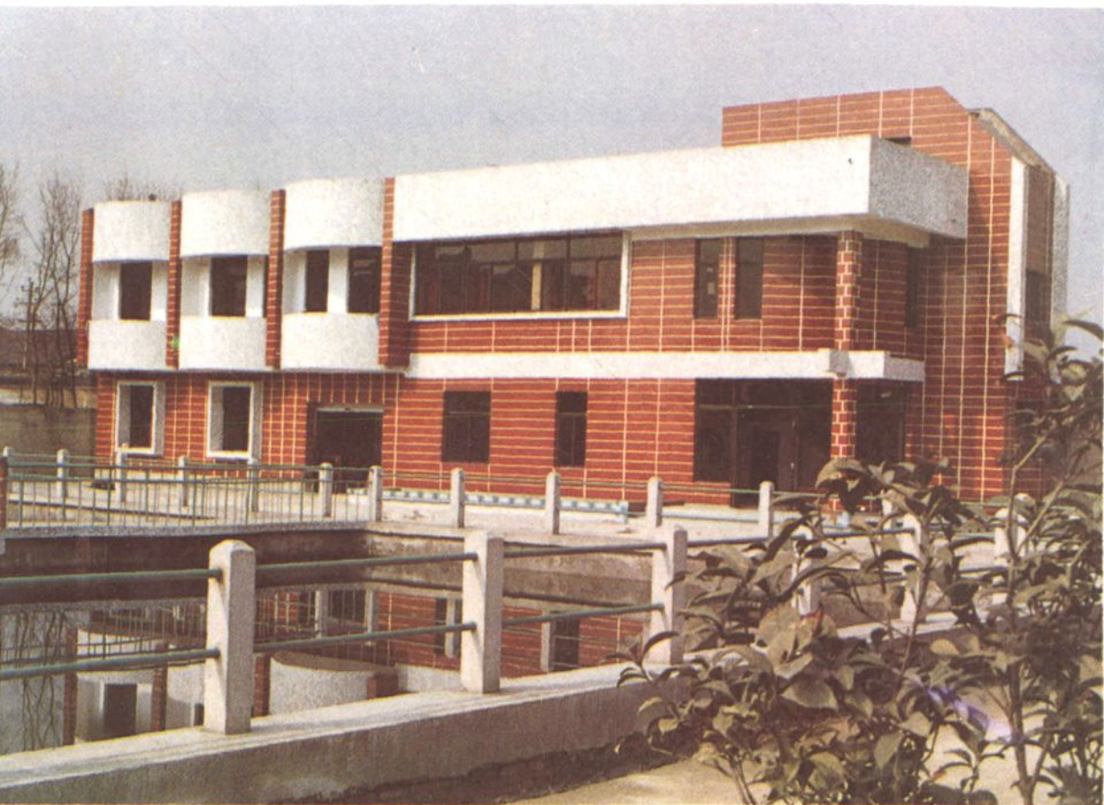
杭州小河油库消防泵房
