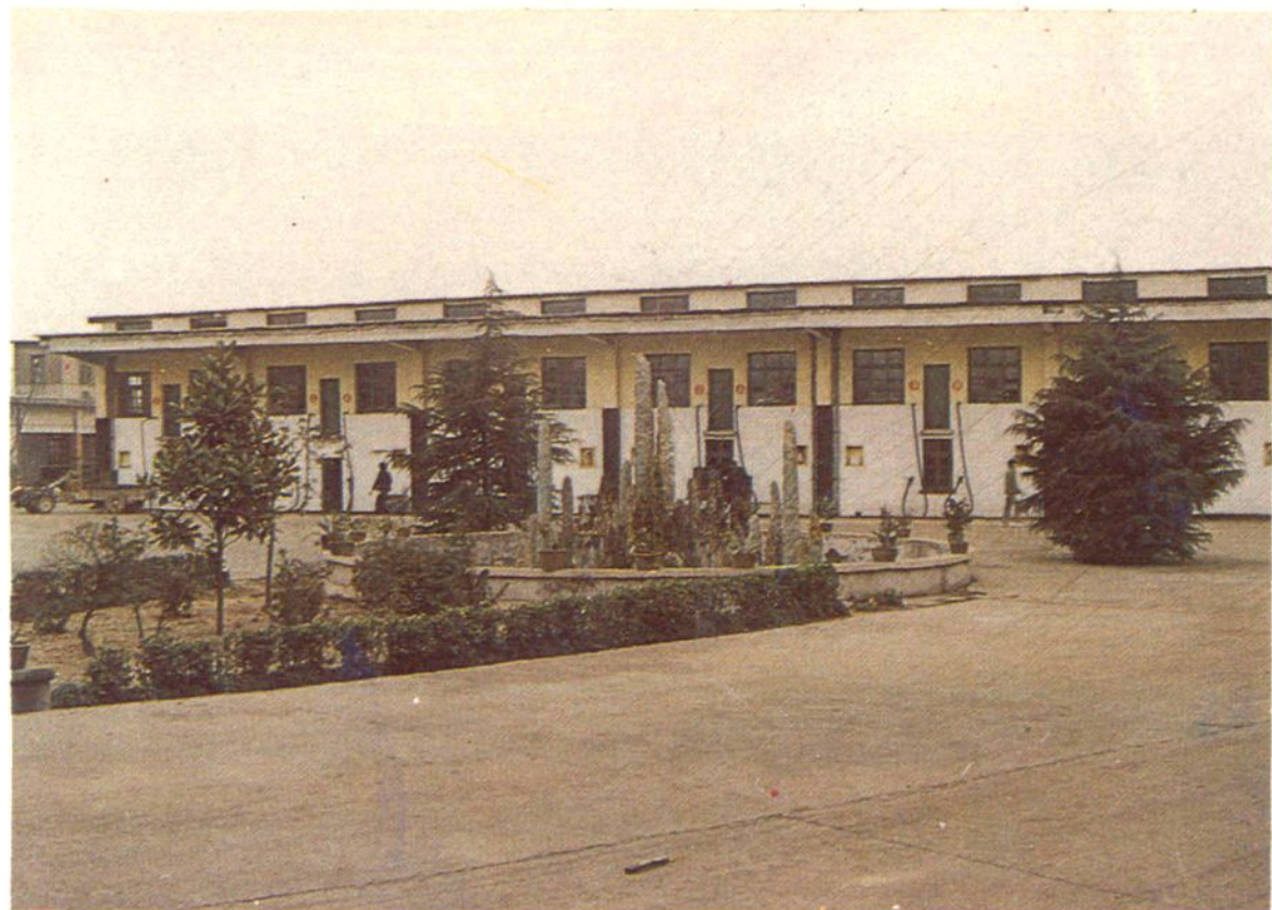
金华河盘桥油库一角
