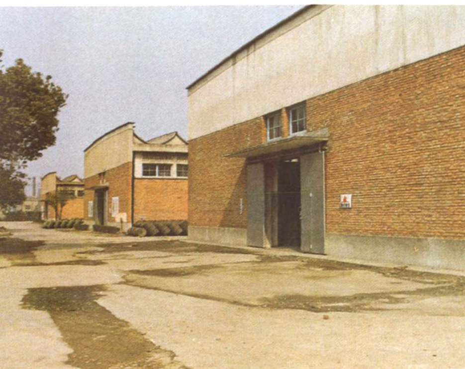
杭州小河油库桶装库房
