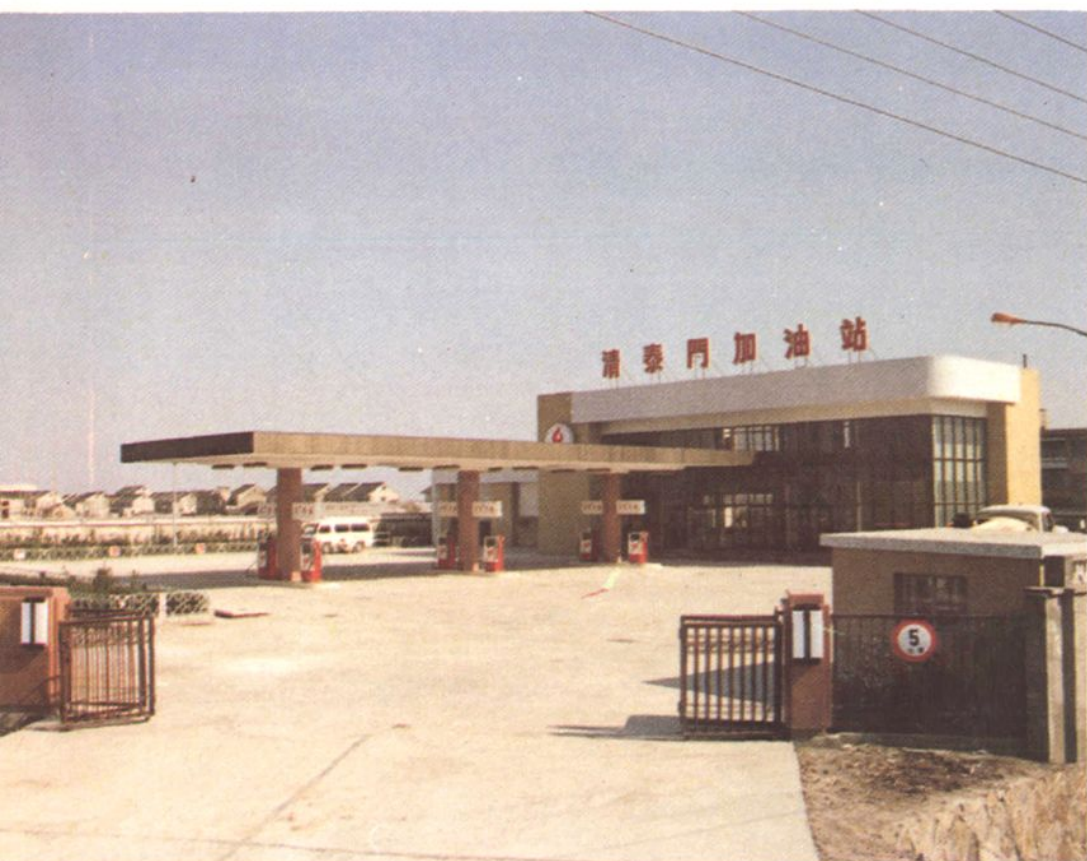
杭州石油分公司清泰门加油站
