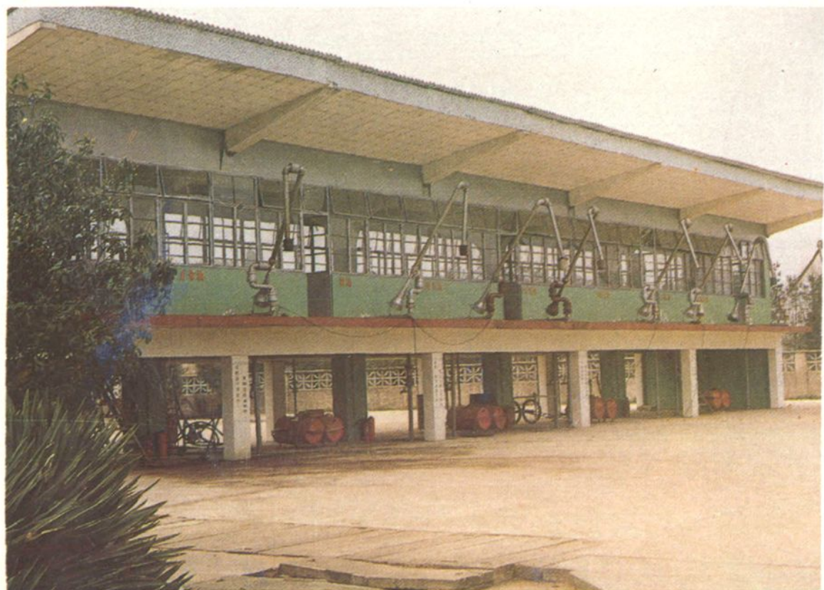
金华古方油库发油台
