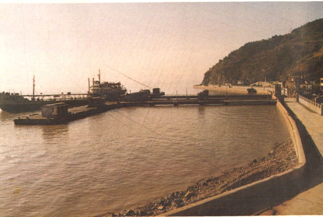
普陀县半升洞油库码头全景
