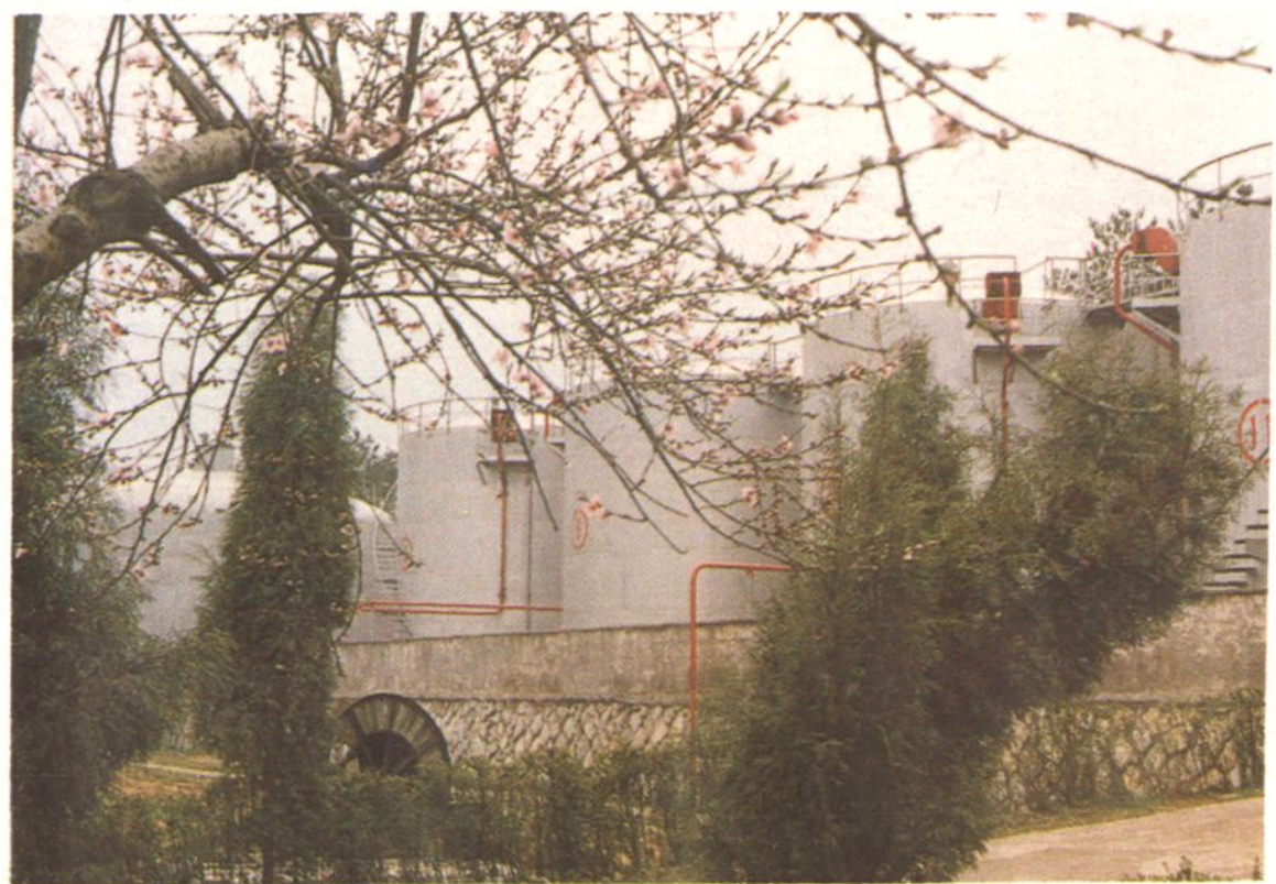
金华古方油库储油罐区
