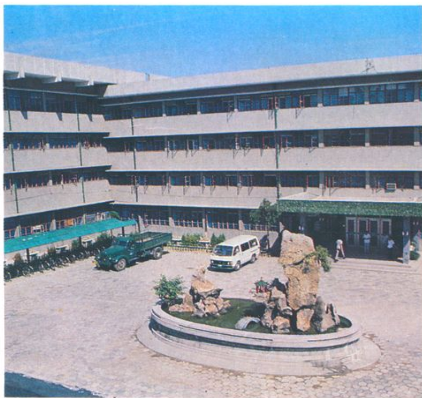
◁ 潍坊烟草分公司办公楼
