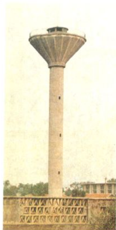
罐头厂倒锥壳水塔 (1986年竣工)
