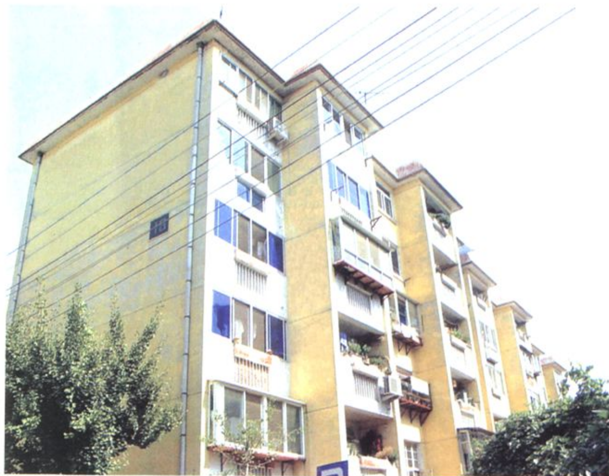
烟台民生小区19#住宅楼 (1988年竣工，全线取得质量第一，总分第一)
