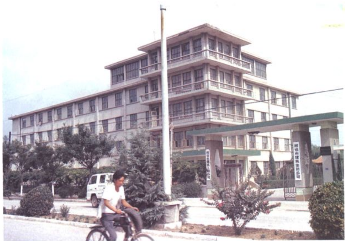
公司大门办公楼(1989—1996)
