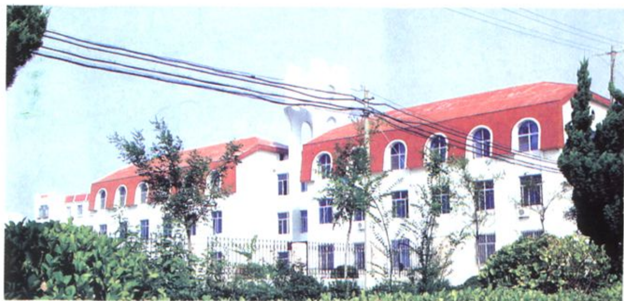
胜利油田浅海公司宿舍楼 (1991年竣工，部优工程)
