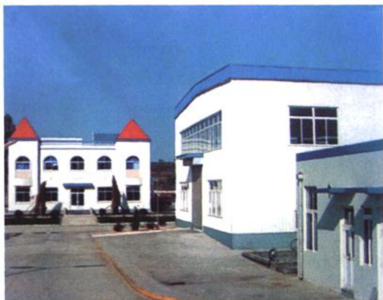
建材厂施工 的外墙涂料 工程
