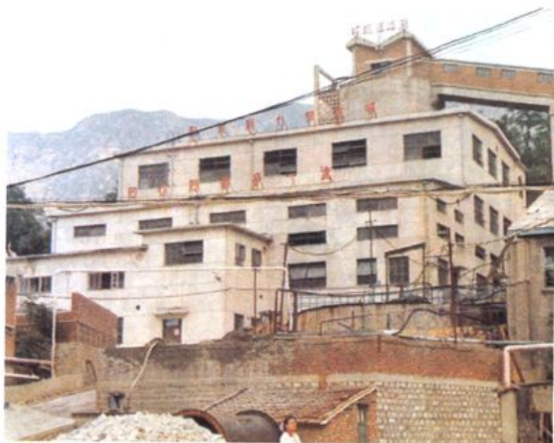
招远金矿1000吨选厂 (1988年竣工)
