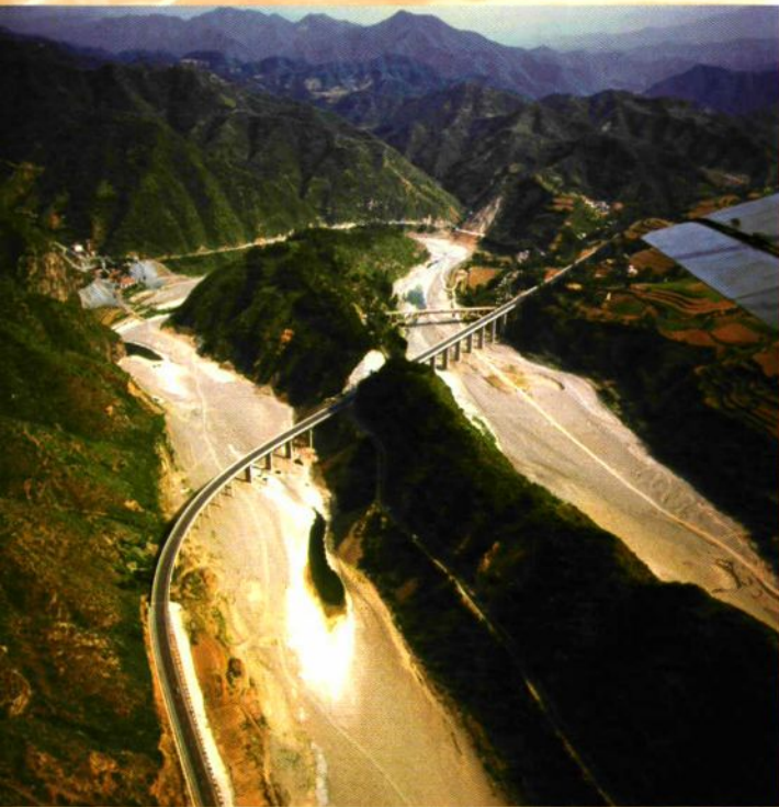
坡、彎多型的前河1號大橋、2號大橋，與前河2號大橋並列的為1969年修建的前河雙曲拱橋
