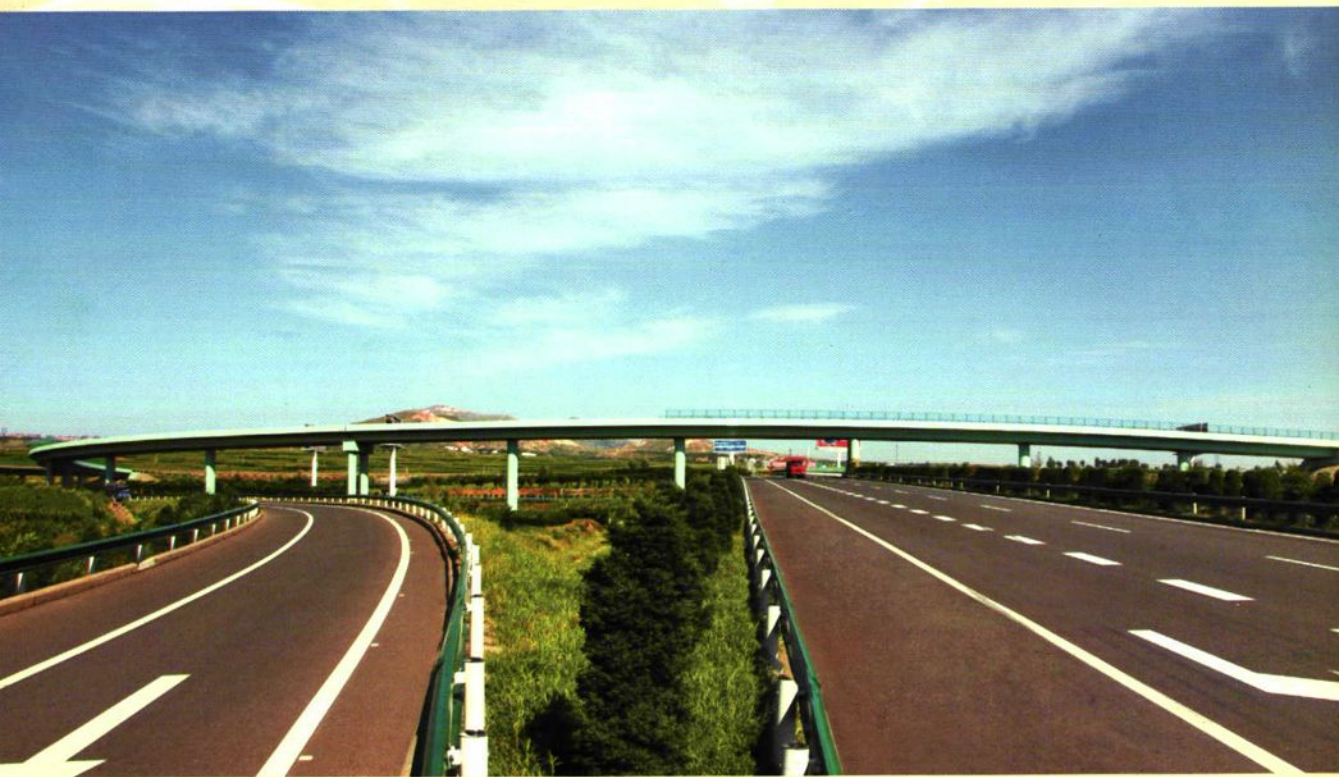
郑少洛高速公路洛阳伊川彭婆立交枢纽
