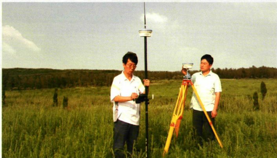
公路测量设计人员采用GPS卫星定位测绘仪器进行野外测量作业
