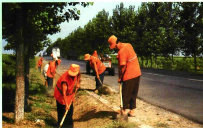
养路工人在精心管护公路路肩、边沟
