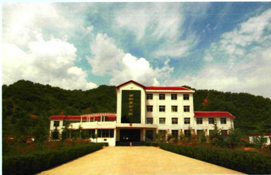
深山里的公路养护道班——栾川合峪养护工区
