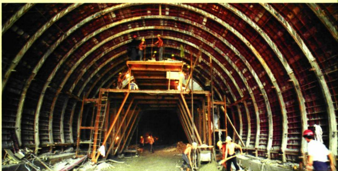
洛栾快速通道前范岭隧道在紧张施工
