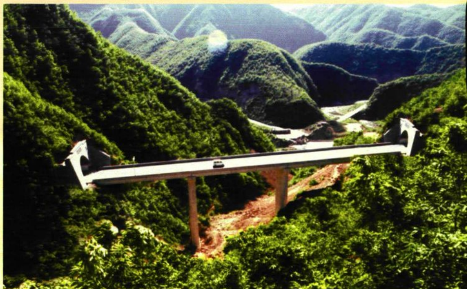
洛栾快速通道嵩县段桥隧相连奇观
