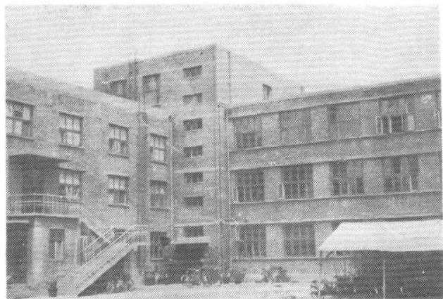
哲盟电影公司办公楼
