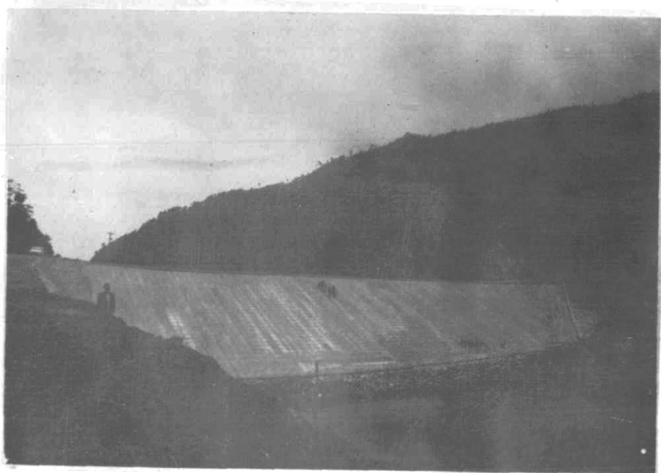
会东县雪山水库坝坡(蓄水 800 万立方米)
