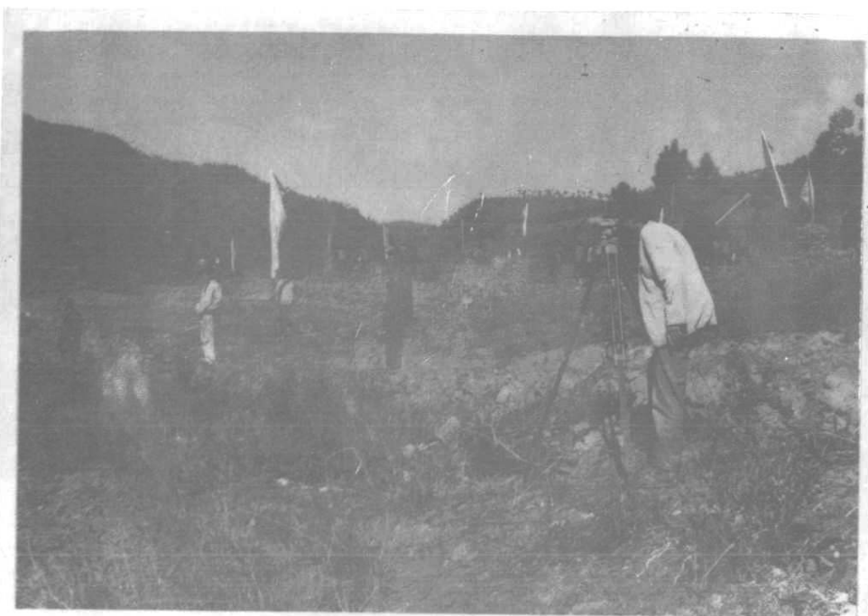
姜州乡水土保持坡改梯工程,技术人员施工放线
