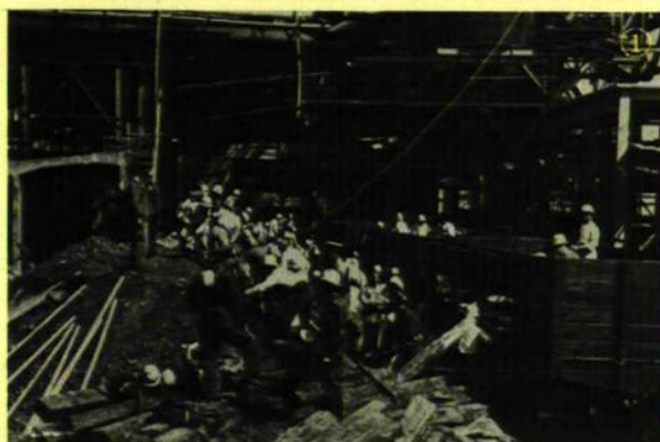
清除废墟：①②③
