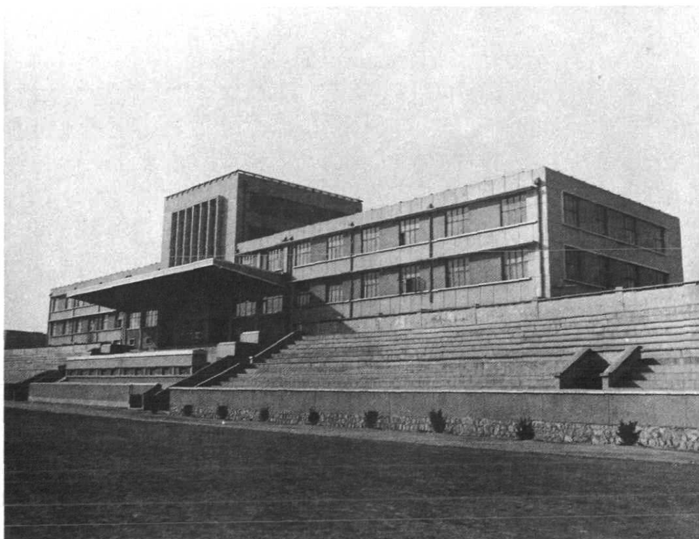
淄博市体育场主楼于1981年建成使用。
