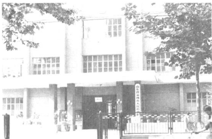
1978年8月淄博市人民检察院 重建后新办公楼照片，驻张店红旗 七路东侧（现改为张店人民西路与 鲁中宾馆毗邻）3号
