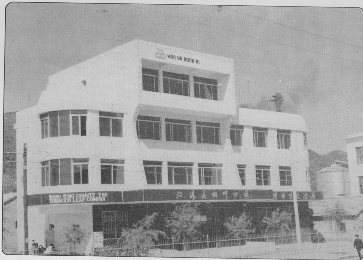
汪清县烟叶公司办公楼一角（1989年8月30日竣工建成使用）
