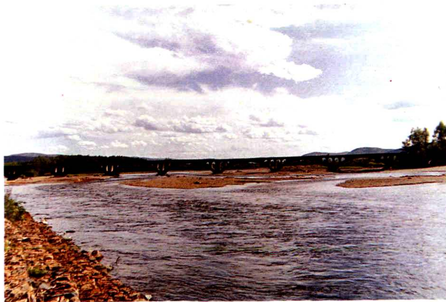
坐落于呼玛河上的呼中大桥
