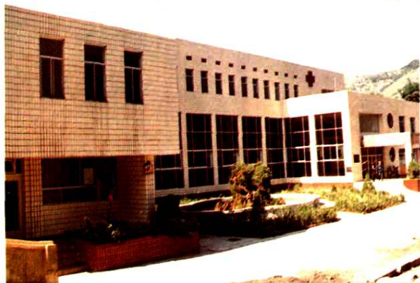
县医院门诊楼
