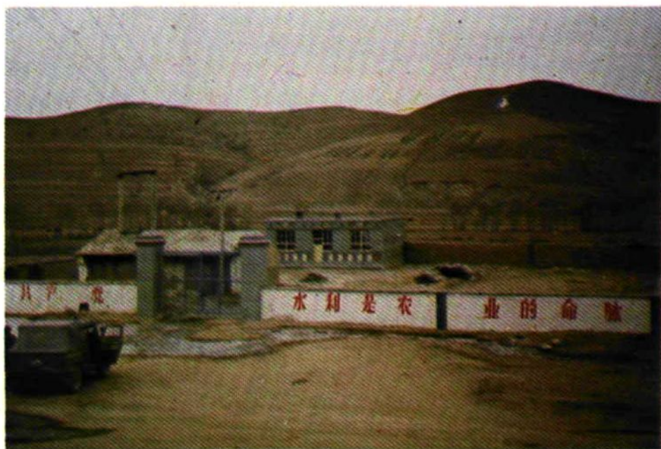
六百户深井供水站
