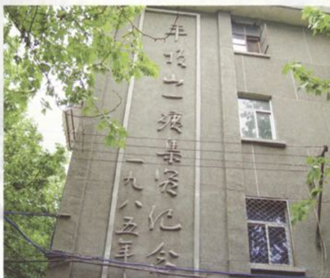
原平顶山矿务局一矿集资兴建的家属楼
