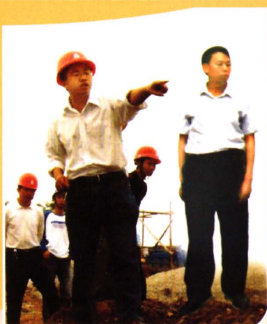
◆县委常委、常务副主任祝绍先（右一）视察佛教文化广场建设工程
