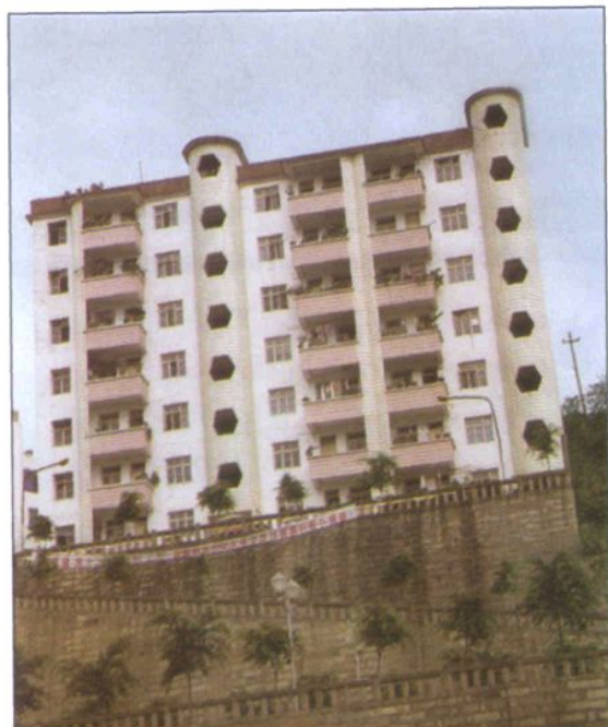
◀国土局综合楼
