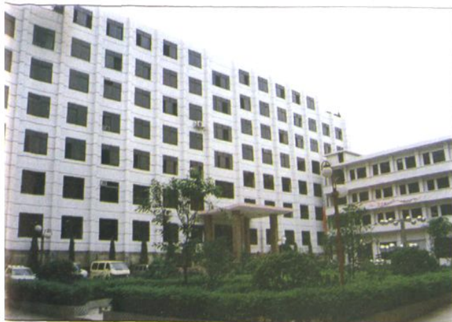
◀中共武隆县委办公大楼
