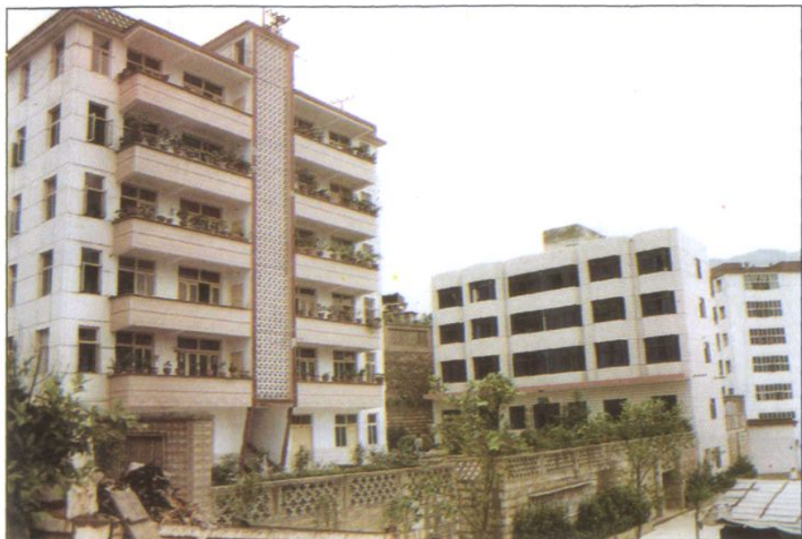
▲移民局办公、住宿楼
