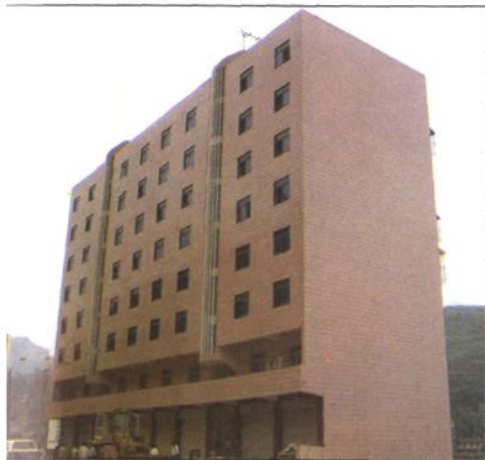
▲县养路队综合楼
