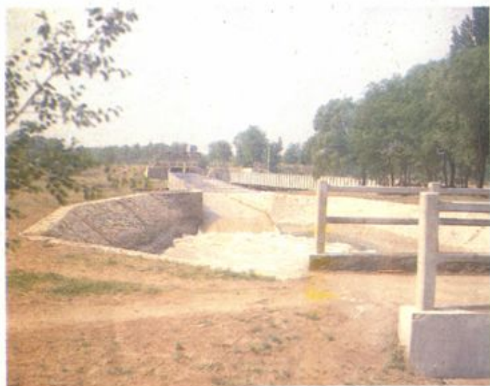
簸箕李灌区跨沙河渡槽
