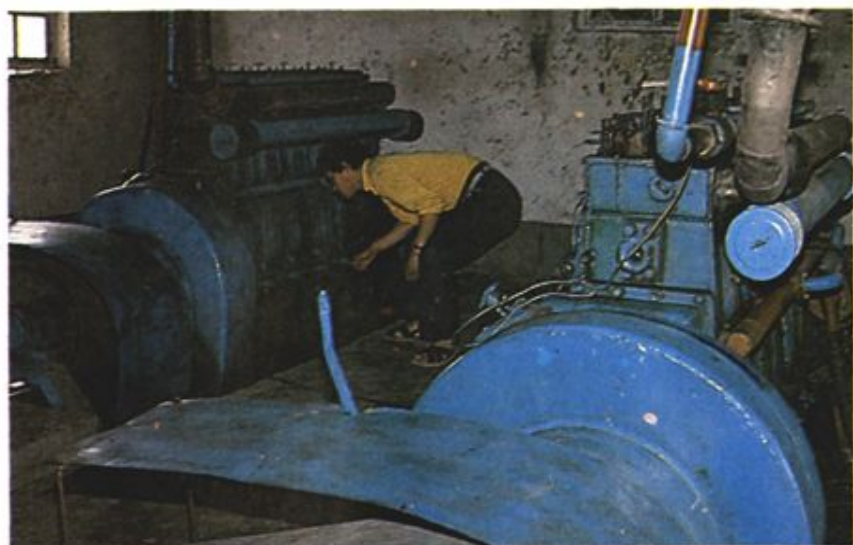
徒骇河湾头孙扬水站机房
