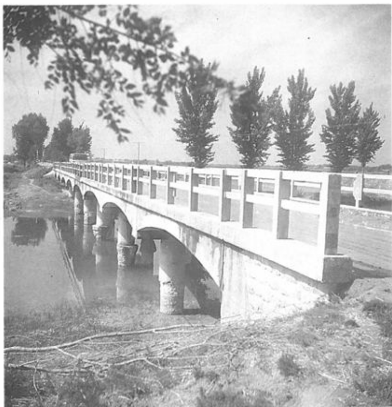
沙河朱杨公路桥
