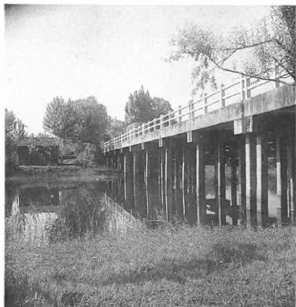
沙河娘娘坟公路桥
