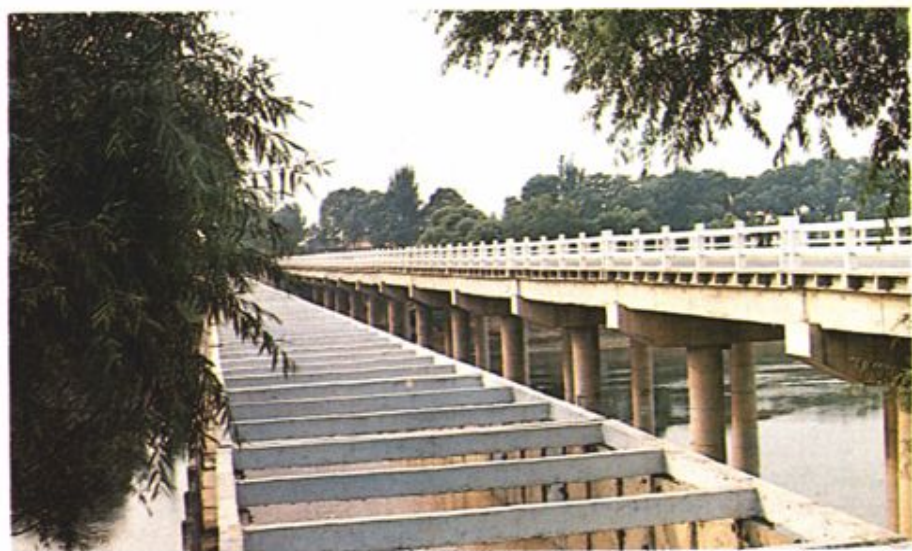
徒骇河刘家公路桥（桥侧为引黄渡槽）
