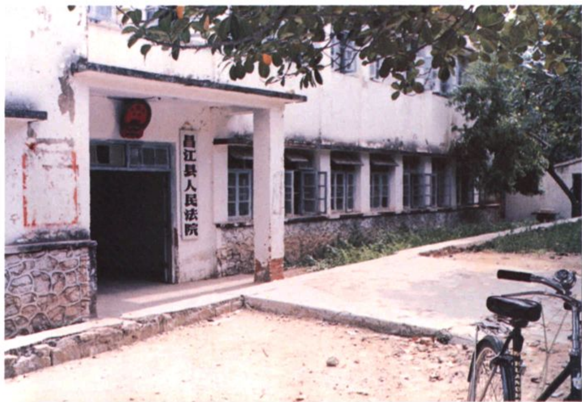
本院原办公大楼
